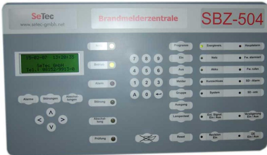
LED-Anzeigen befinden sich im oberen Teil der Zentrale. Darunter befinden sich optional die 8er-LED-Gruppenfelder für die Meldergruppen-Einzelanzeigen.
