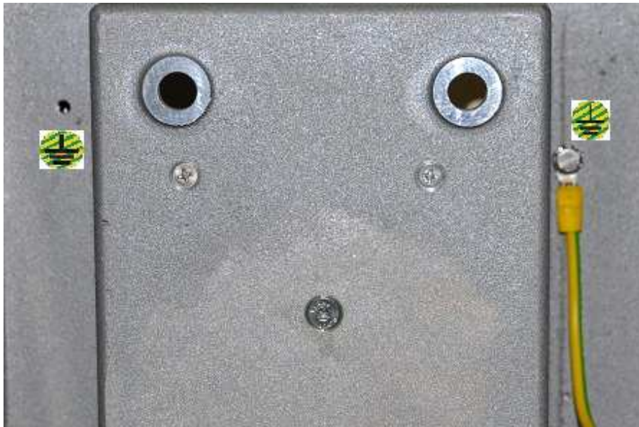
Anschluss der Erdung wahlweise links oder rechts
