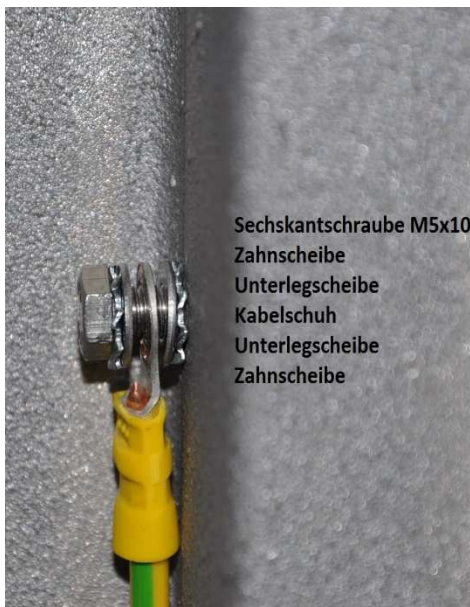
Angeschlossene Erdung
