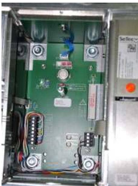
Aufgrund der **engen Platzverhältnisse** ist beim elektrischen Anschluss unbedingt darauf zu achten, dass die Adern des Anschlusskabels relativ flach und „parallel“ zueinander liegen. Es sollten möglichst wenige Aderkreuzungen auftreten. Ebenso sollte die Kabelisolierung nur ein Stück in das SD hineinreichen.
